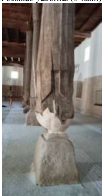
6-rasm. Ustunni sxematik chizmasi va ta‘mirlangan holatini ko‘rinishi
